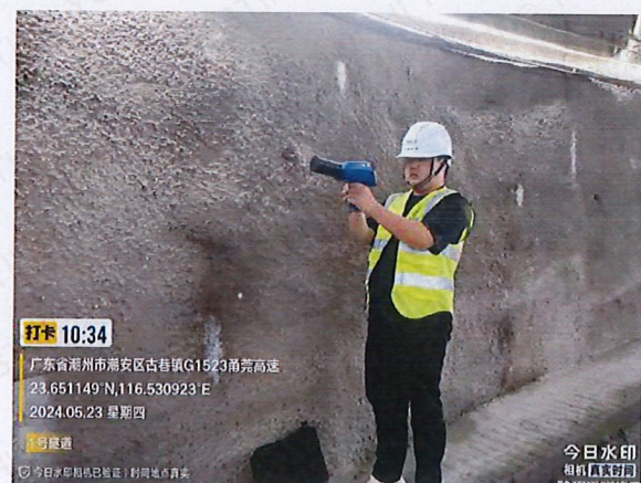
主干线隧洞段 1#支洞 50 米处
