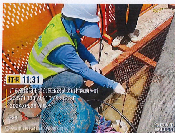
施工 2 标 GX8 生产废水
