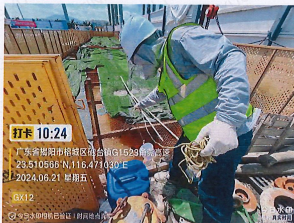
施工 2 标 GX12 生产废水
