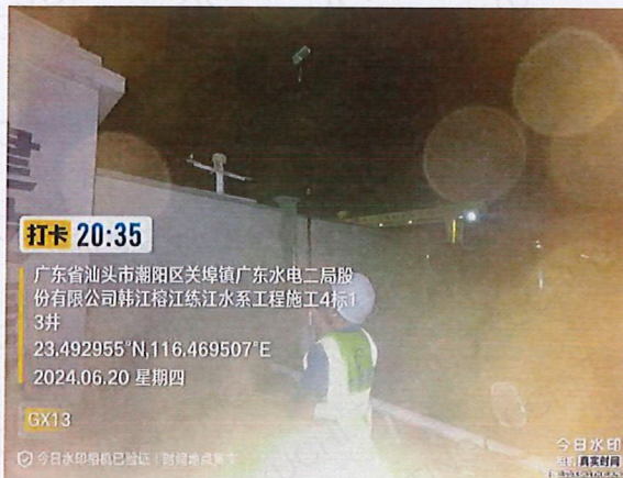
施工 4 标 GX13（北）侧外 1 米 1#
