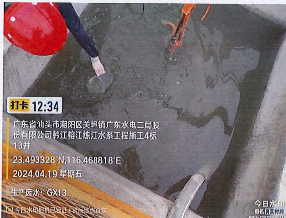
施工 4 标 GX13 生产废水
