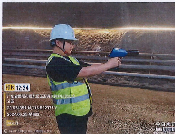
主线隧洞段 3#支洞 450 米处
