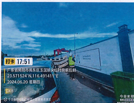
施工 2 标 GX8（西）侧外米 1#
