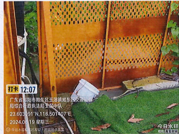
施工 2 标 GX6 生产废水
