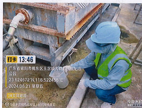
施工 1 标 3#支洞隧道洞口排水
