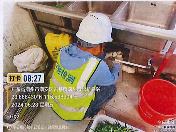
施工 1 标 GX2 厨房生活污水
