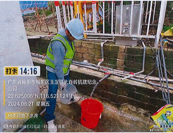
施工 1 标 3#支洞地下水井
