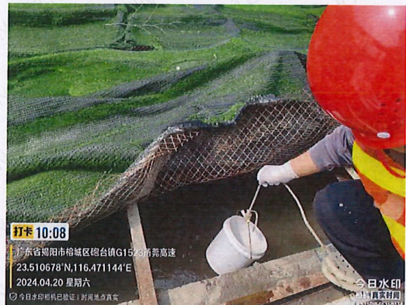
施工 2 标 GX12 生产废水
