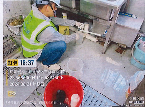
施工 1 标 GX2 厨房生活污水
