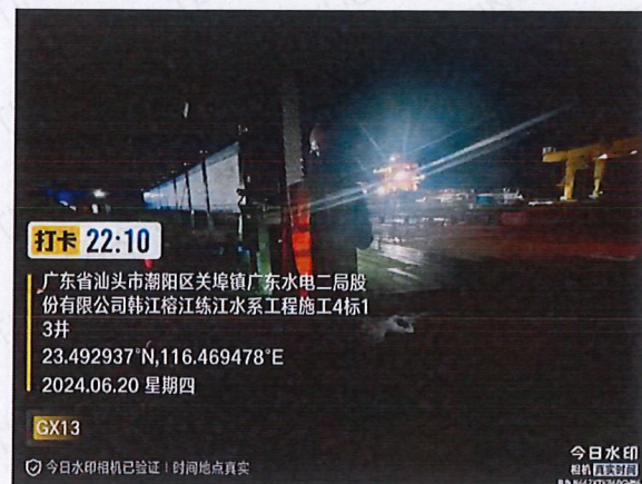
施工 4 标 GX13（南）侧外 1 米 2#
