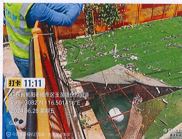
施工 2 标 GX6 生产废水
