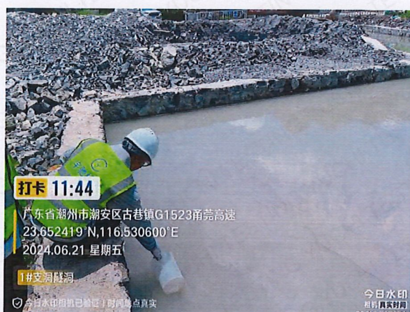
施工 1 标 1#支洞隧道洞口排水
