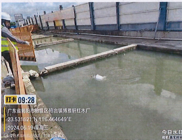
施工 2 标 GX11 生产废水
