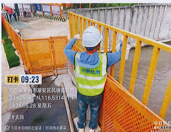
施工 1 标 2#支洞隧道洞口排水
