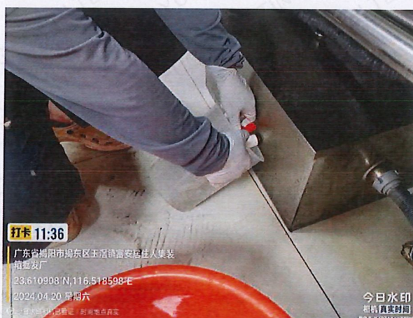
施工 3 标 GX5 厨房生活污水（1 号点）
