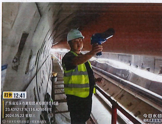
TBM 隧道洞口开端 350 米处
