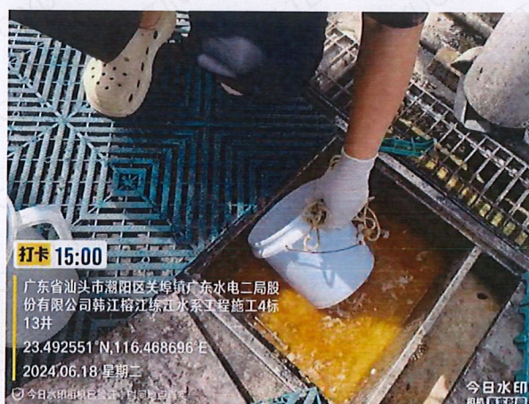
施工 4 标 GX13 厨房生活污水
