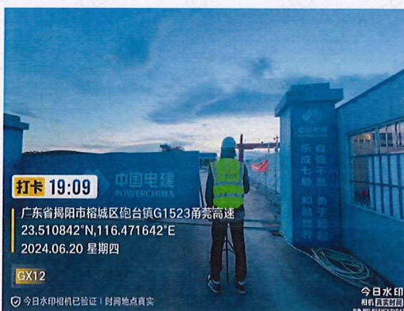
施工 2 标 GX12（西）侧外米 1#
