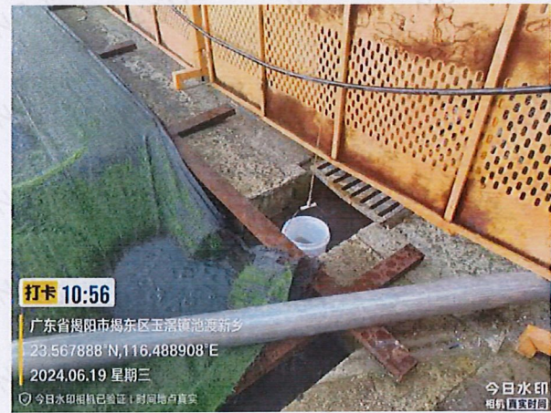
施工 2 标 GX8 生产废水
