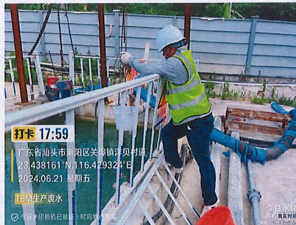
施工 5 标 TBM 隧道开端洞口排水
