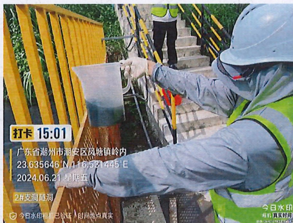
施工 1 标 2#支洞隧道洞口排水
