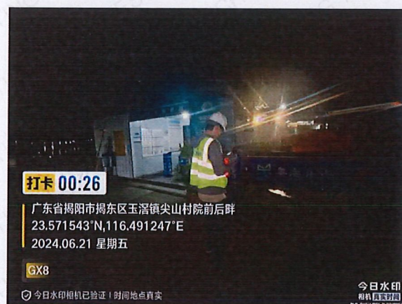
施工 2 标 GX8（南）侧外米 2#
