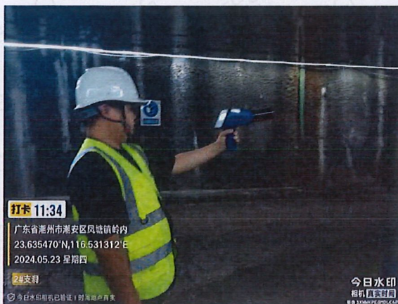
主线隧洞段 2#支洞 50 米处
